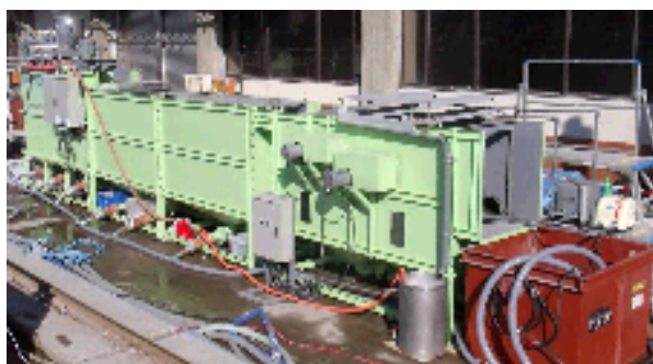
写真-1 濁水処理設備設置状況
