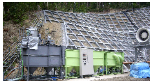
写真-4 濁水処理設備設置状況
